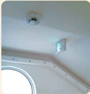
최상층 계단 천장에 단독경보형감지기 설치 우수
